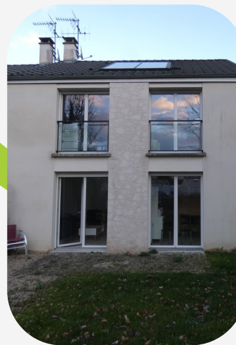
Appartements partagés localisés à Epernay
